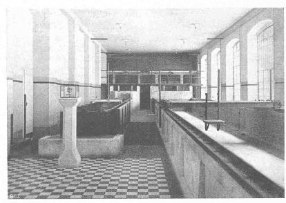
Abb, 12. Versuch-Gerinne im Flussbau-Laboratorium der Technischen Hochschule Wien.
