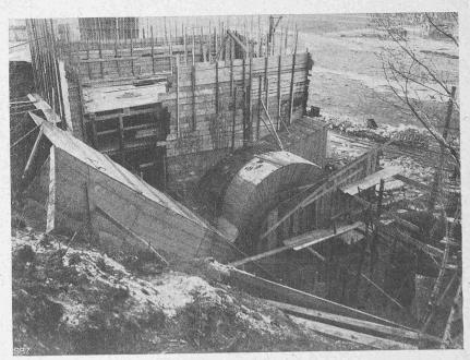
Abb. 13. Verschalung des Ventilatorenhauses (vergl. auch Abb. 14).
