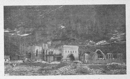
Abb. 15. Neues Ventilatorenhaus (links) und Portal II (rechts) im Bau.
