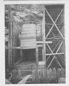
Abb. 14. Ventilatoren-Verschalung.
