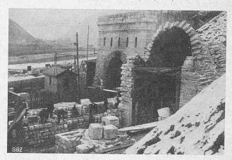
Abb. 16. Portal II im Bau, rechts "Pfeife" zu Tunnel II.
