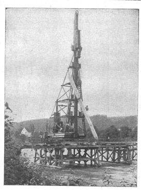
Vom Bau der Eisenbahnbrücke über die Aare bei Däniken. Rammung der Pfahljoche mit Eisenbetonpfählen, Syst. Züblin.
