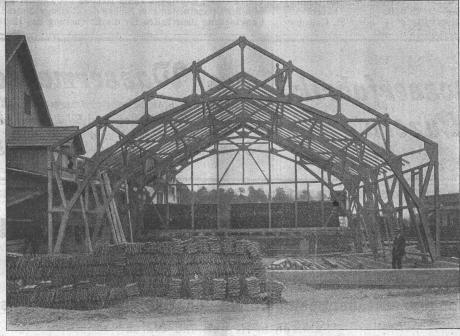
Zweigelenkbinder in System Holzfachwerk für Lagerhaus Olten.
