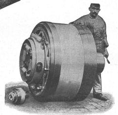
Benn Kupplung Nr. 12 für 600 PS gellefert in eine Zementfabrik.
