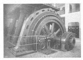
Abb. 9. Ansicht des Drehstrom-Schwungrad-Generators.
