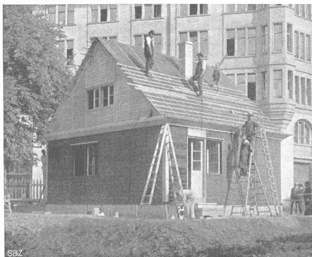
Abb. 21. Baufortschritt am 30. Juli 1919 nachmittags.
