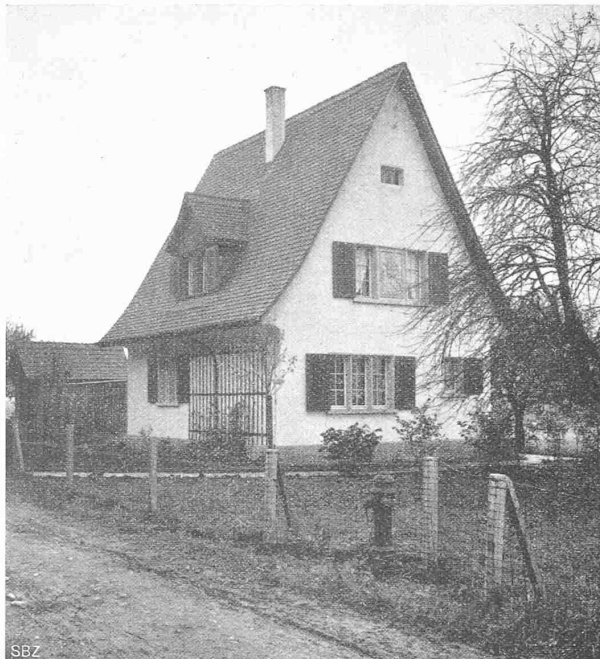
Abb. 11. Haus Arch. F. Ulrich, von Nord-Ost.
