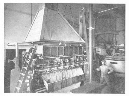
Abb. 4. Walzentrockenapparat in der Kartoffel-Trocknungsanlage Payerne.
