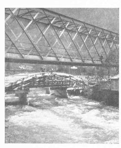
Abb. 9. Lehrgerüst bei Mittelwasser
