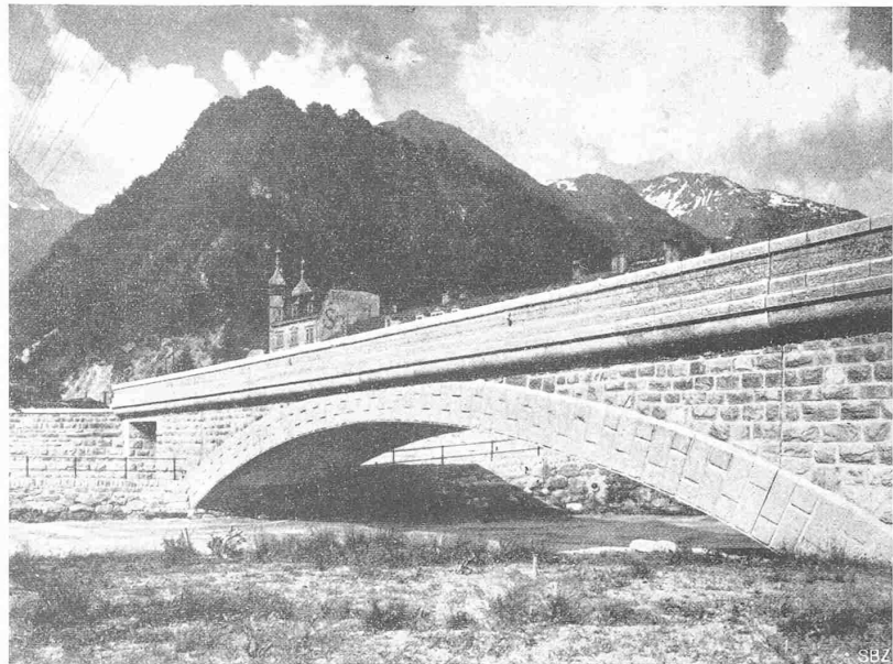
Abb. 11. Ansicht des Hauptbogens, Seite flussabwärts, gegen NO gesehen.
