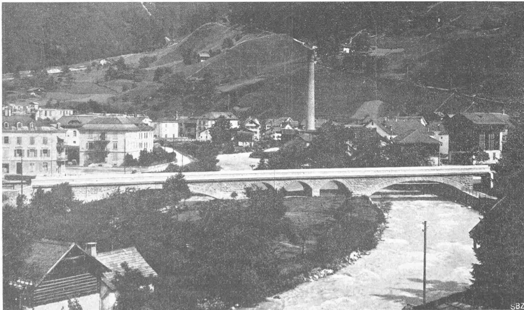
Abb. 4. Die neue Eisenbahnbrücke der S. B. B. bei Schwanden, aus Nordwesten gesehen.
