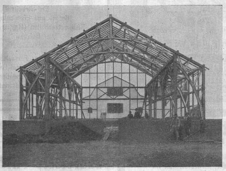
Zweigelenkbinder mit Kranbahn für 6 Tonnen Kran in Holzfachwerk Waagenfabrik STUDER in Olten
