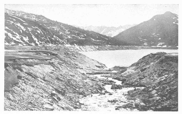
Abb. 6. Einfressen des Tomsee-Abflusses bei seiner Mündung in den Ritom-See (östlich von Punkt B in Abb. 2), 9 Monate nach Absenkung.
