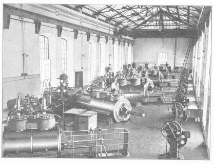
Abb. 17. Gesamtansicht des Maschinensaals der neuen Pumpanlage. Maschinelle Ausrüstung von Gebrüder Sulzer A.-G, in Winterthur.
