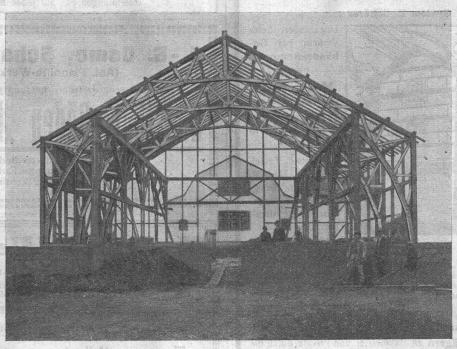
Zweigelenkbinder mit Kranbahn für 6 Tonnen Kran in Holzfachwerk Waagenfabrik STUDER in Olten
