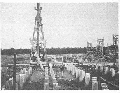
Abb. 7. Rammen der Eisenbetonpfähle für das Kessel- und das Maschinenhaus.
