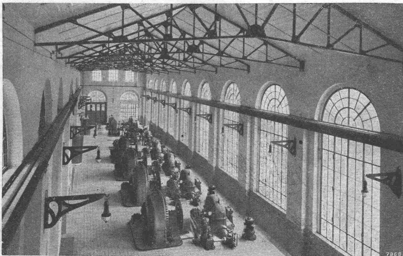
Wasserkraftwerk Cairasca und Diveria. 4 Einheiten von je 3000 kW, und 2 Einheiten von je 1200 kW.
