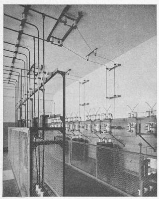
Abb. 28. Abgehende Leitungen und Ueberspannungschutz.
