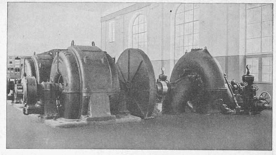
Abb. 23. Ansicht eines 3500 PS-Maschinen-Aggregats im Kraftwerk Massaboden.
