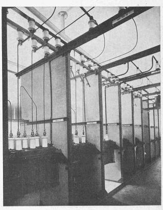
Abb. 27. Schalter für die Generatoren und Motoren,
