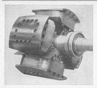
Abb. 25. Polrad des Drehstrom-Generators von 2700 kVA.
