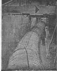
Druckrohr in Eisenbeton von 2 m Durchmesser d Wasserkraftanlage Stöcklin & Cie., Basel, 1916/17.
