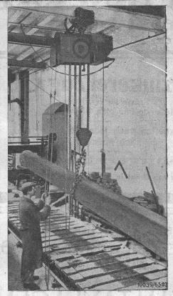
Elektroflaschenzug von 4000 kg Tragfähigkeit, mit Unterflanschlaufkatze.
