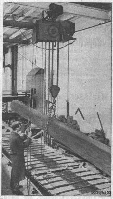
Elektroflaschenzug von 4000 kg Tragfähigkeit, mit Unterflanschlaufkatze.
