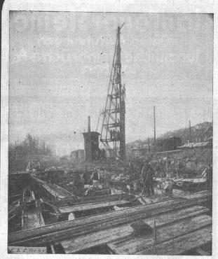
Postgebäude St. Gallen. Rammung der Eisenbetonpfähle, System Züblin.
