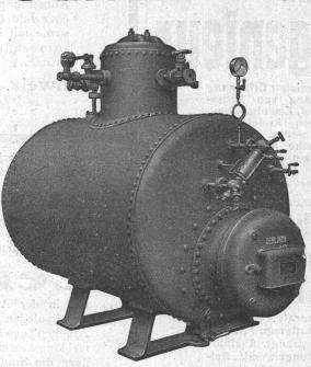
Elektrischer Dampfkessel für 120 kW Aufnahme
