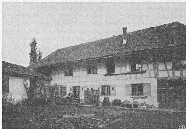
Abb. 9. Mittlere Mühle in Oberwinterthur, Rückseite (Ostseite).
