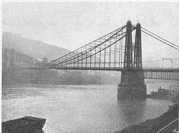
Abb. 4. Steife Hängebrücke über den Monongahela in Pittsburg.
