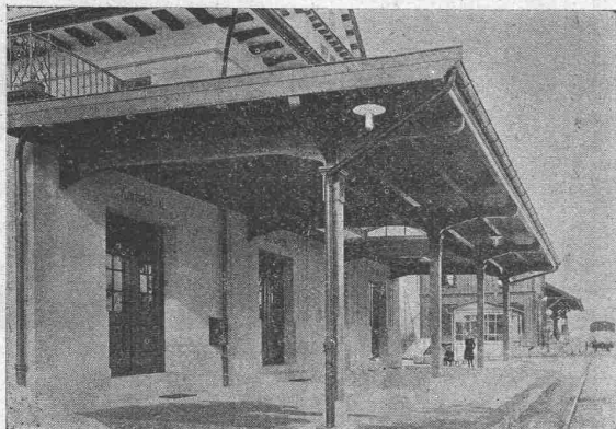
Perrondach Oberwinterthur. Frei aufliegende Konsolträger.
