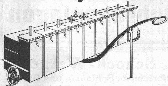
für stündliche Gasleistungen bis zu 50 000 Kubikmeter z. Autogenschweissen im Hoch- und Tiefbau, Eisenbahn- und Brückenbau, Werften, Thermogenarbeiten, Beleuchtungs- und Scheinwerferanlagen usw., nach den Patenten
