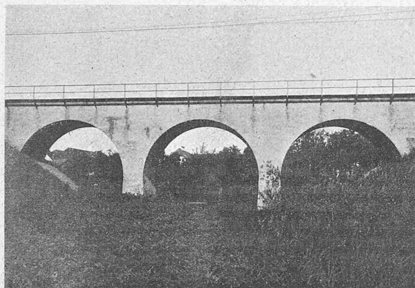
Abb. 18. Urtenen-Brücke (Stampfbeton).
