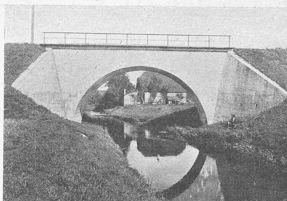
Abb. 20. Limpach-Brücke (Stampfbeton).
