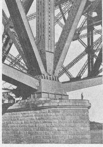
Abb. 5. Strompfeiler-Detail der Quebec-Brücke.
