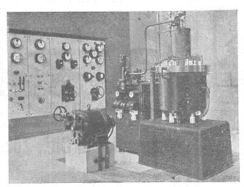
Komplette Gleichrichter-Anlage. Primär: Dreiphasenstrom, 12000 Volt, Frequenz 50. Sekundär: Gleichstrom 70 kW, 220 bis 260 Volt.
