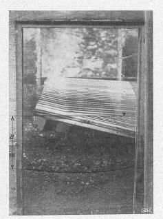
VI. Reihe (Nr. 31 bis 33, Abbildung 7). Sicherung mit nicht dicht aneinander gelegten Betonblöcken verschiedener Grösse.
