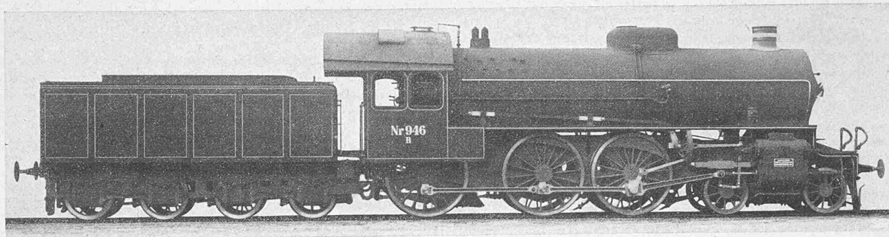
Abb. 2. \frac{3}{4} gekuppelte Heissdampf-Schnellzuglokomotive, Klasse F, der Dänischen Staatsbahn.
