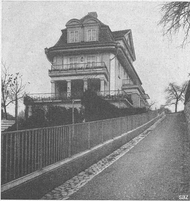
Abb. 8. Talseitige Schmalfront von unten (Dolderstrasse).
