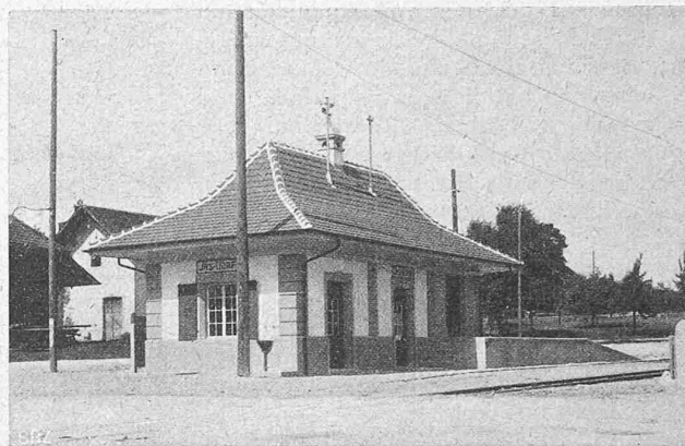
Abb. 17. Station Ins-Dorf der Biel-Täuffelen-Ins-Bahn.
