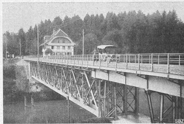
Abb. 15. Ansicht vom rechten Ufer des Hagneck-Kanals.
