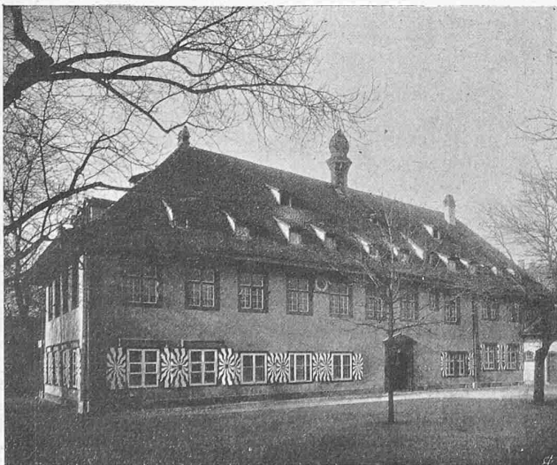
Abb. 5. Rückseite (Ostfront) des umgebauten Schützenhauses. Die beiden Fensteraxen am Ende rechts gehören zum Neubau.
