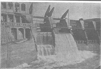
Zwei von sleben selbsttätigen Ueberfallwehren, je 10,00 m breit, 6,00 m hoch, der Stauanlage Riegos y Fuerza del Ebro S. A. Tremp (Spanien).
