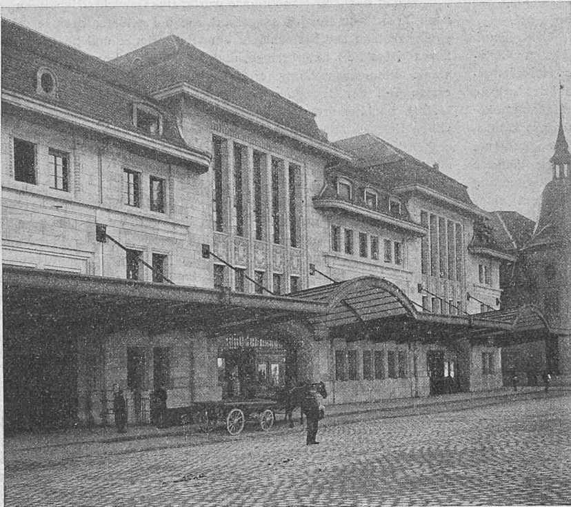
Abb. 7. Westlicher Flügel des Aufnahmegebäudes.
