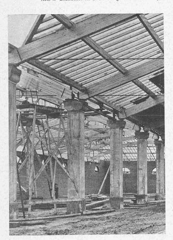
Abb. 10. Mittelpfeiler und Dachkonstruktion im Bau.
