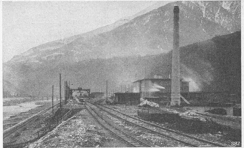
Abb. 33. Installationsplatz Nordseite mit Umladekran (rechts die Zementsteinfabrik Hunziker).
