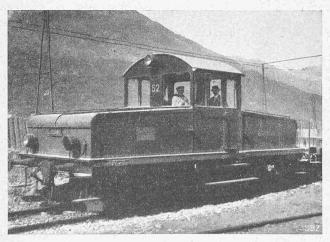
Abb. 24. Akkumulatoren-Lokomotive der Maschinenfabrik Oerlikon.
