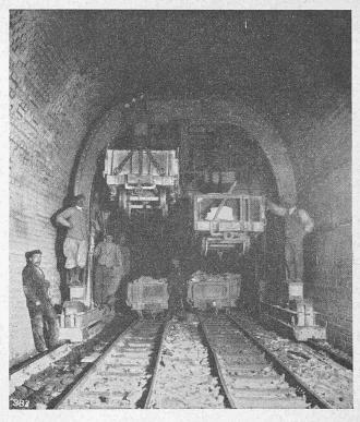
Abb. 30. Tunnelkran mit gehobenen Türenwagen.
