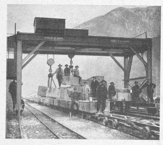
Abb. 32. Fahrbarer Umladekran auf dem Installationsplatz Brig, gebaut von der "Giesserei Bern" der v. Rollschen Eisenwerke.
