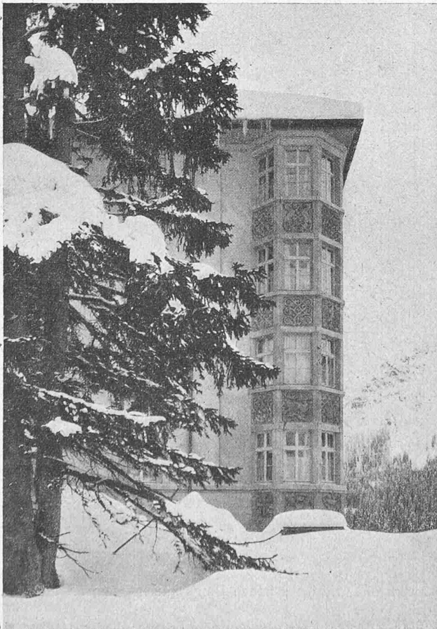
Abb. 12. Nordost-Ecke des Sanatoriums.
