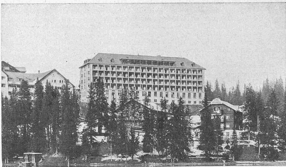
Abb. 11. Das Sanatorium Altein von Süd-Südwest; gegenwärtiger Zustand seiner Umgebung.
