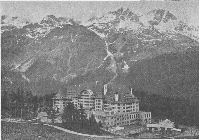
Abb. 3. Nordwestansicht mit dem Küchenbau.
