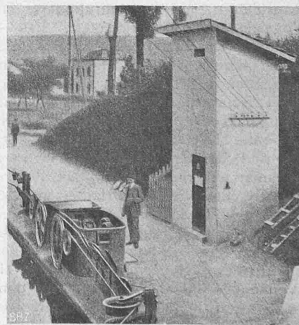
Abb. 2. Antriebswinde mit Transformatorstation.
