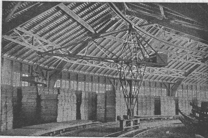
Velozipedkran für 700 kg Tragkraft, 7,2 m Ausladung und 4,5 m Hub in der Verladehalle der Eternitwerke Niederurnen.
