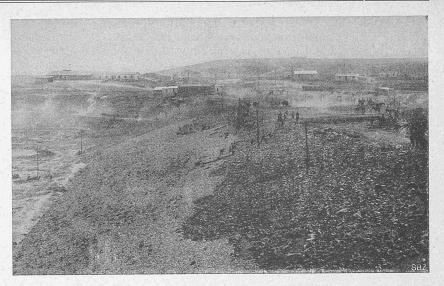
Abb. 69. Steinpflästerung der Wasserseite von Damm Nr. 3. (3. Sept. 1913).
