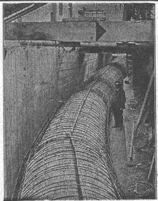
ruckrohr in Eisenbeton von 2 m Durchmesser der Wasserkraftanlage Stöcklin & Cie., Basel 1916.
