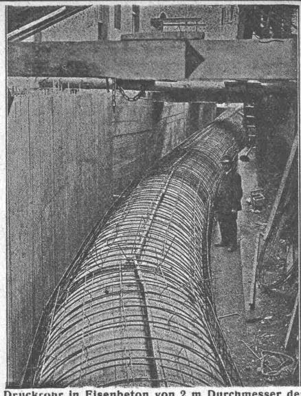
Druckrohr in Eisenbeton von 2 m Durchmesser der
