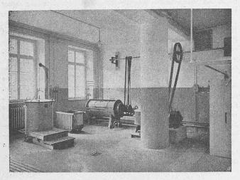
Abb. 22. Waschküche mit Dampftrocknerei im Zellenbau.
