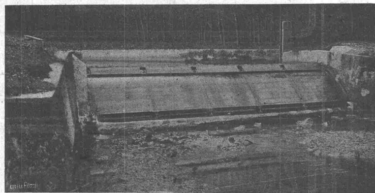
Zwei von sieben selbsttätigen Ueberfallwehren, je 10,00 m breit, 6,00 m hoch, der Stauanlage Riegos y Fuerza del Ebro S. A. Tremp (Spanien).
