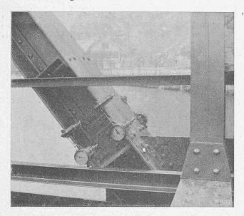
Abb. 3. Dehnungsmesser von Mantel (an einer Fachwerk-Strebe).
