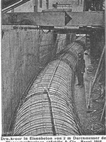
Druckronr in Eisenbeton von 2 m Durchmesser of Wasserkraftanlage Stöcklin & Cie., Basel 1916.
