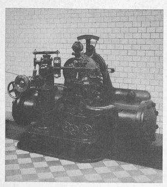
Abb. 28. EWC-Turbinenregulator Modell 1916 im Kraftwerk Augst.
