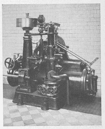
Abb. 27. Abgeänderter Turbinenregulator im Kraftwerk Augst.
